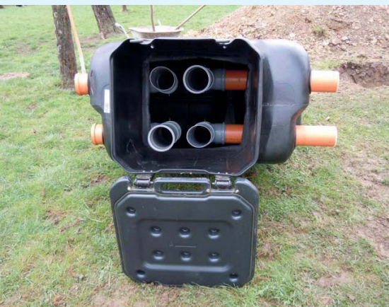
Im Bau befindliche Anlage mit bisher kleinster Tauchkammer für 6 EW in Ost-Thüringen
